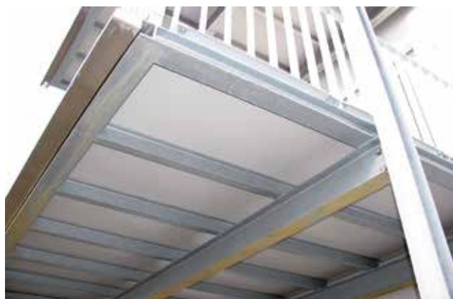
Onderconstructie / Dragende delen
